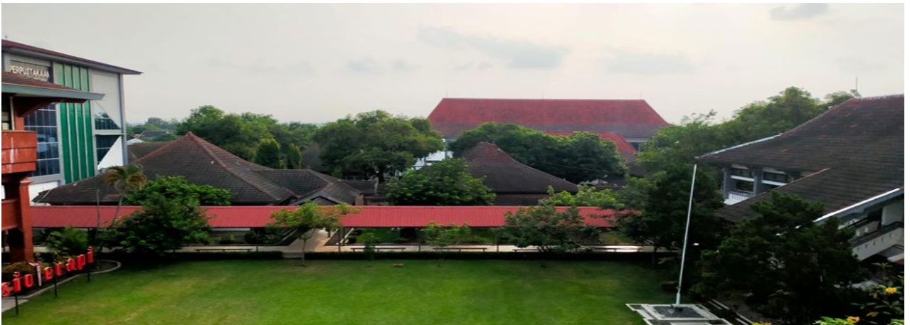
Selasar yang menghubungkan semua ruangan
